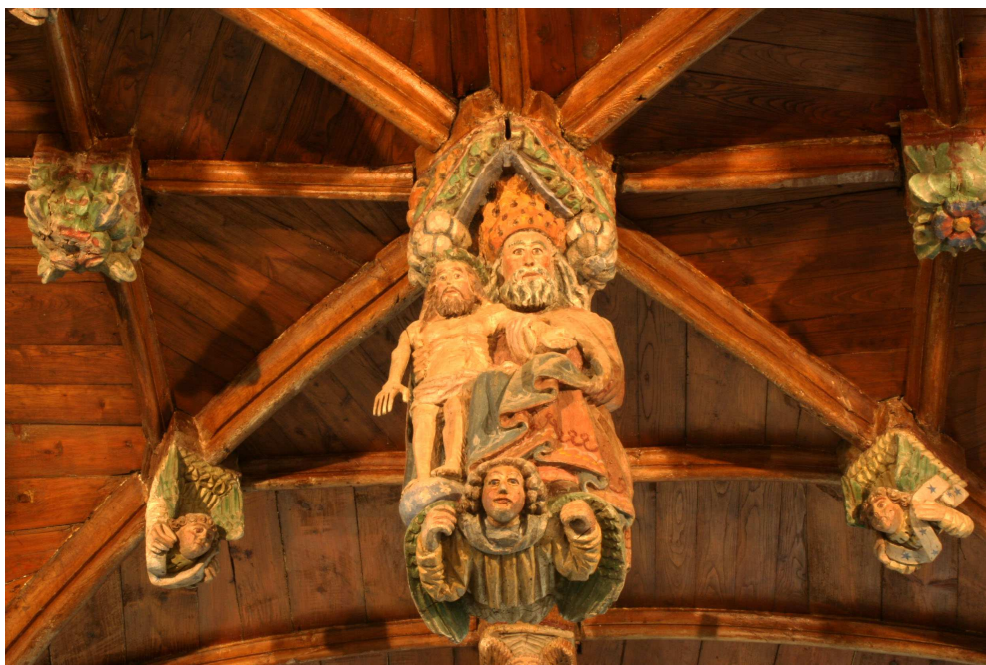
Voûte de l'église de Loc-Envel (22)
